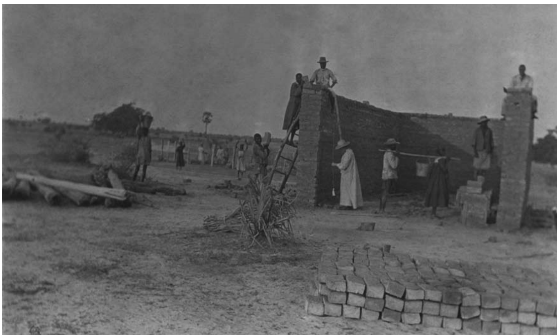
Selma Rainio mäter vagnrummets vägg på byggplatsen för sjukhuset i Onandjokwe.
