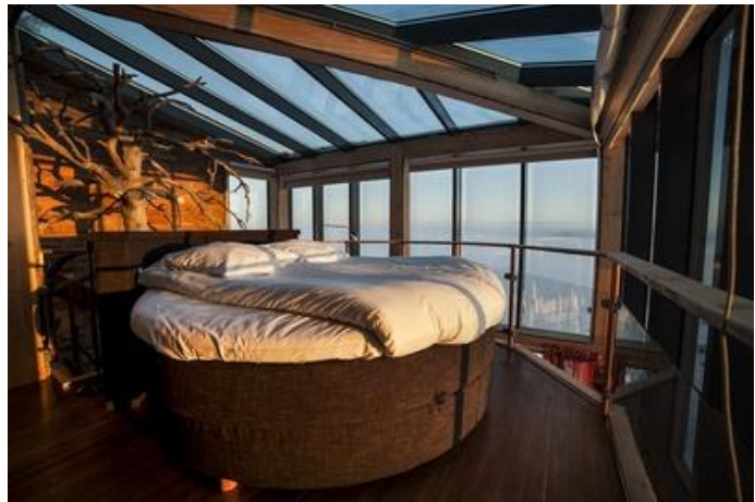
Iso-Syöteen Kotkanpesän sähkölämmitteiset näköalaikkunat ja valokatteet. ©Hotelli Iso-Syöte.
